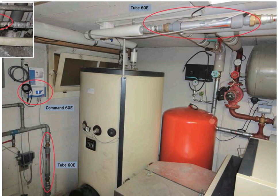
Tube de contrôle sur le Retour d'Eau Chaude Sanitaire (Retour ECS) du bâtiment
