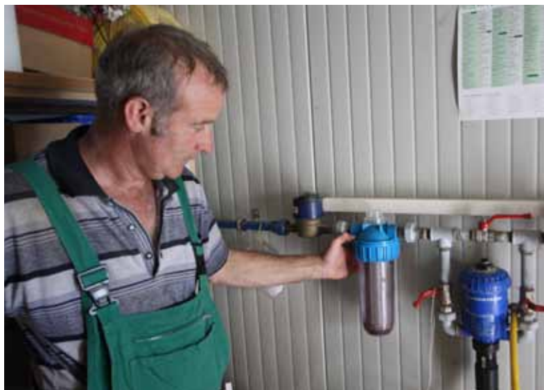
Früher musste Franz Scheucher den Wasserfilter wöchentlich reinigen. Jetzt reicht eine Reinigung pro Mastdurchgang.
